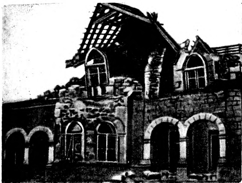
Рис. 222. Разрушения из-за плохого материала. Балаклава, Крым, 1927 г.
