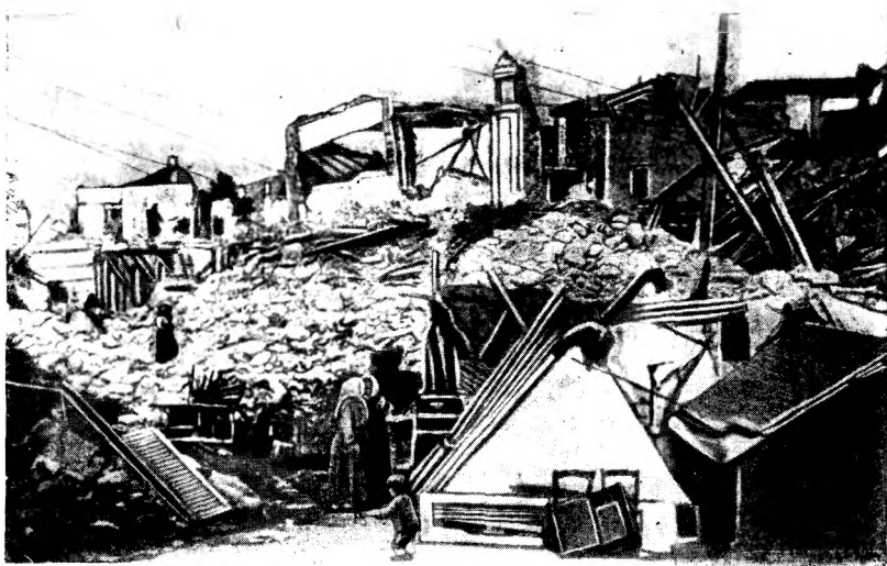
Рис. 261. Сильное разрушение в городе Сан-Джовани. Мессинское землетрясение 28 декабря 1908 г.
