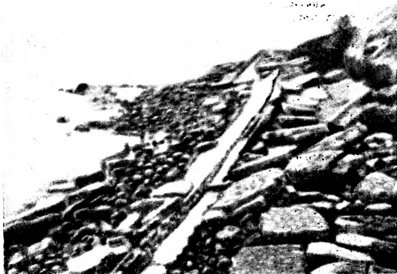
Рис. 254. Защитная стена на берегу Балтийского моря на острове Узедом, разрушенная при урагане в декабре-январе 1913—1914 гг.
